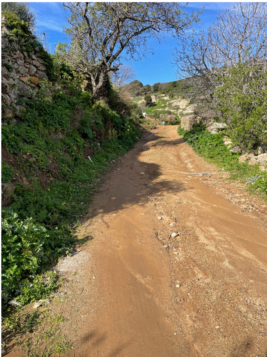
Chemin communal à élargir et desservant des maisons existantes et des habitations en construction
